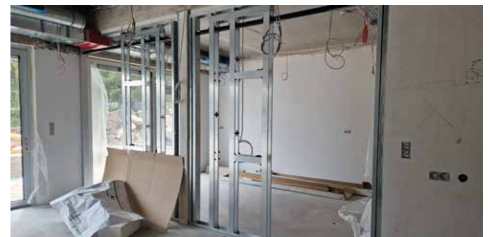
Das Gebäude in der Endphase der Fertigstellung
